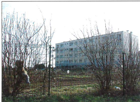
La cité de Malogne, regroupant habitat et jardin collectif, se trouve au sud du Parc d'Activités de Grévaux-les-Guides.
