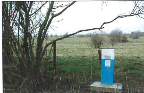
Sur le terrain, des piquets et bornes matérialisent la canalisation de gaz, alors que des bornes basses signalent celle d'air liquide.
